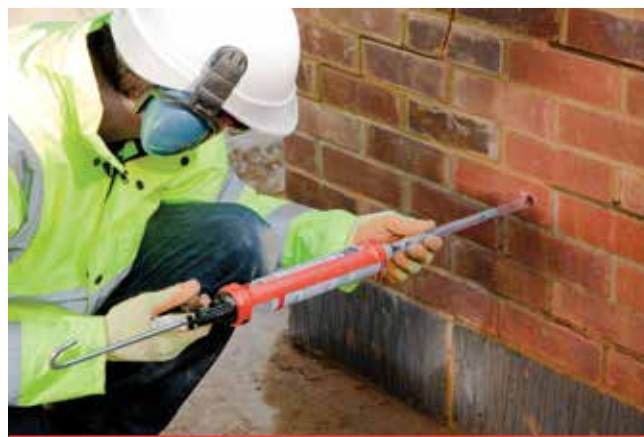
Hars inspuiten om de installatie van de RetroTie te voltooien
