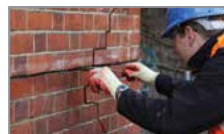
4. Gebruik het Helibar voegijzer om één HeliBar in de mortel te duwen om een goede dekking te verkrijgen
