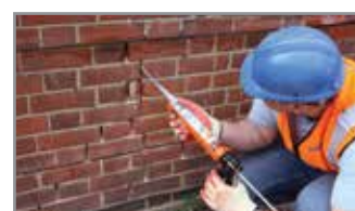
6. Voeg het mortelbed opnieuw en herstel de verticale scheur met CrackBond TE3
