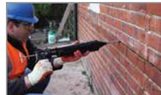
5. Breng opnieuw een ril HeliBond aan over de zichtbare HeliBar en eindig 12 mm van het oppervlak. 'Strijk' stevig in de sleuf met behulp van het Helibar voegijzer
