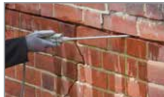
2. Reinig de sleuven en spoel ze met schoon water en doordrenk het element in de sleuf grondig
