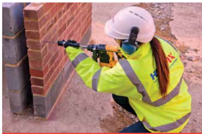
DryFix anker wordt met boor in gat gedreven
