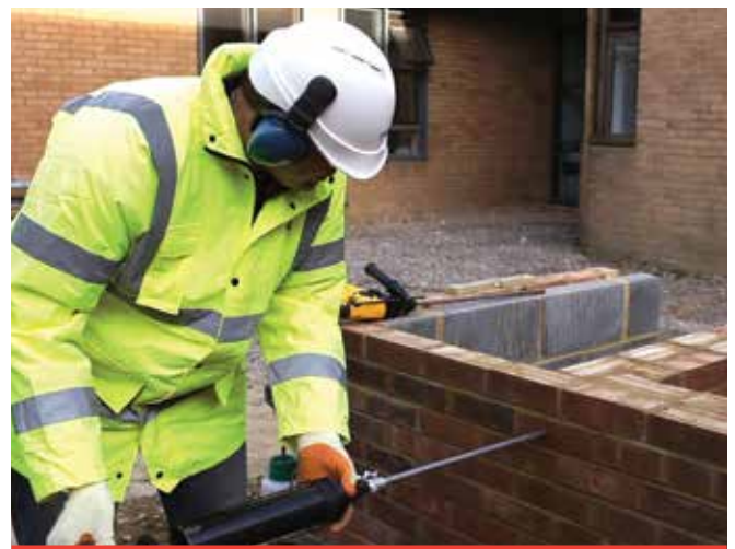
Het met mortel gevulde mondstuk met de CemTie in het gat steken
