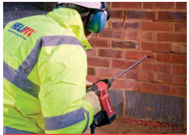
Boren van gat voor installeren van BowTie in balkuiteinde
