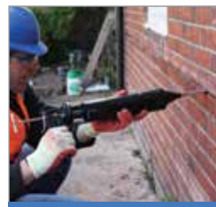
4 De sleuf verder opvullen met HeliBond
