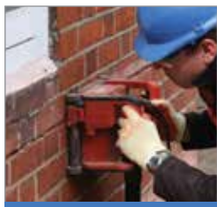
1 Horizontale sleuven in het uitspoelen met water
