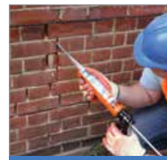
5 De sleuf opnieuw voegen en de verticale scheur afwerken
